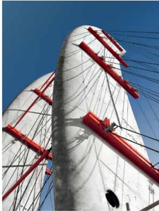
Диаметр каждого троса составляет 66 мм
