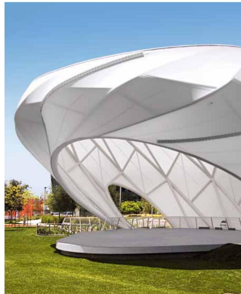
БЕЗУСЛОВНАЯ ВЫГОДА КАРКАСНО-ТЕНТОВЫХ КОНСТРУКЦИЙ ЗАКЛЮЧАЕТСЯ В ТОМ, ЧТО ОНИ НА 100% ДЕМОНТИРУЕМЫ И ТРАНСПОРТИРУЕМЫ В ДРУГИЕ МЕСТА
